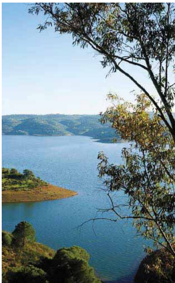
Barrage d'Odeleite (HR)
